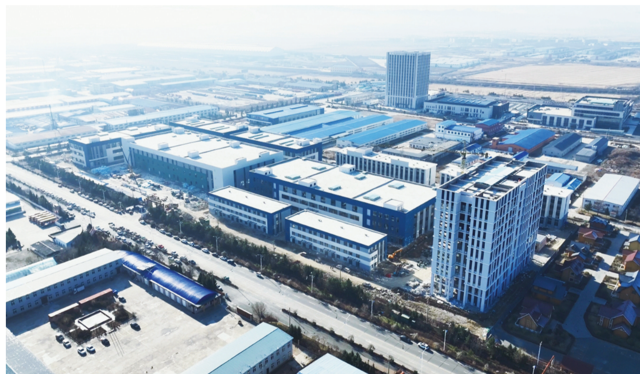
总投资6亿元的吉林珲春海洋经济示范区冷链物流基地示范项目进展顺利。目前,项目主体工程已完成,正在进行内部装修及室外管网铺设、路面硬化等工作。项目建成后,将依托示范区落地加工政策,积极承接海产品加工、储运、转销等企业入驻。
