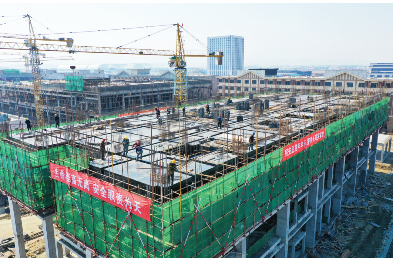
图为吉林珲春海洋经济示范区冷链物流基地示范项目施工现场。
