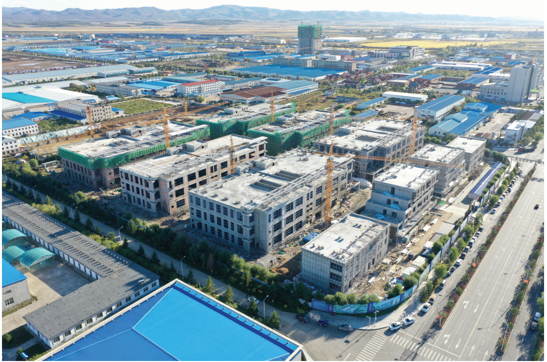
珲春市互市贸易进口商品落地加工基地项目建设现场 本报记者 郎晓 摄
